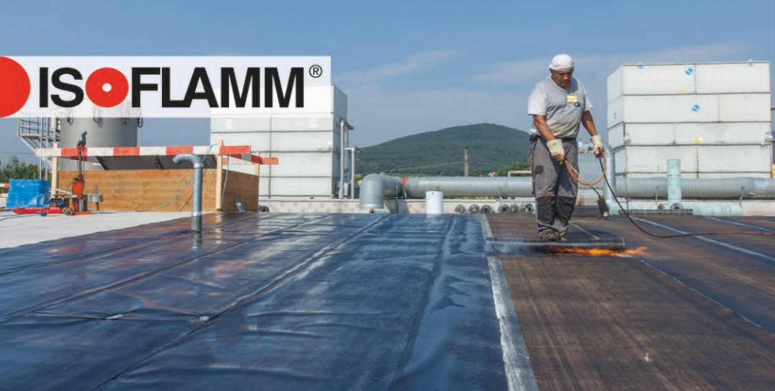
Nahtschweißung mit Handschweißgerät
