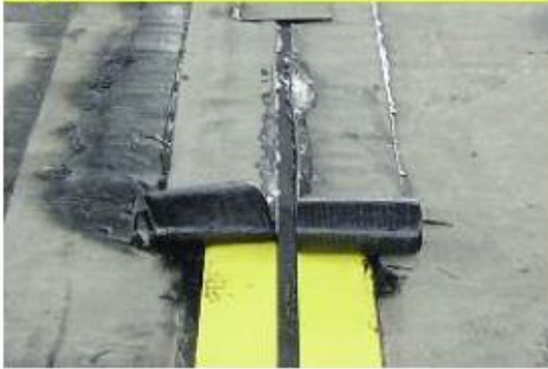
Planebener Einbau (keine störenden Schlaufen und Wülste)
