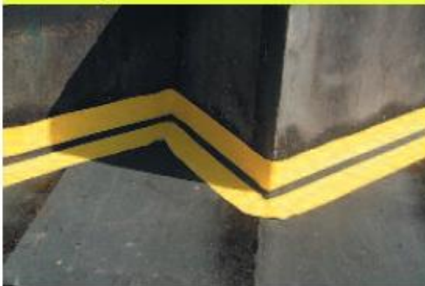
Bänder und Formstücke werden als fertig konfektionierte Systeme auf Ihre Baustelle geliefert und folgen somit jedem Fugenverlauf.
